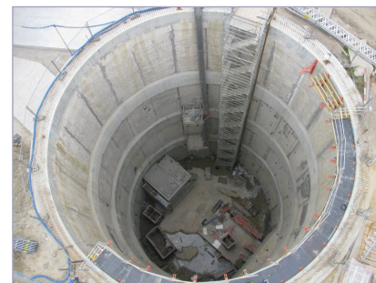
Oszyszczalnia ścieków Czajka – szyb odbiorczy
